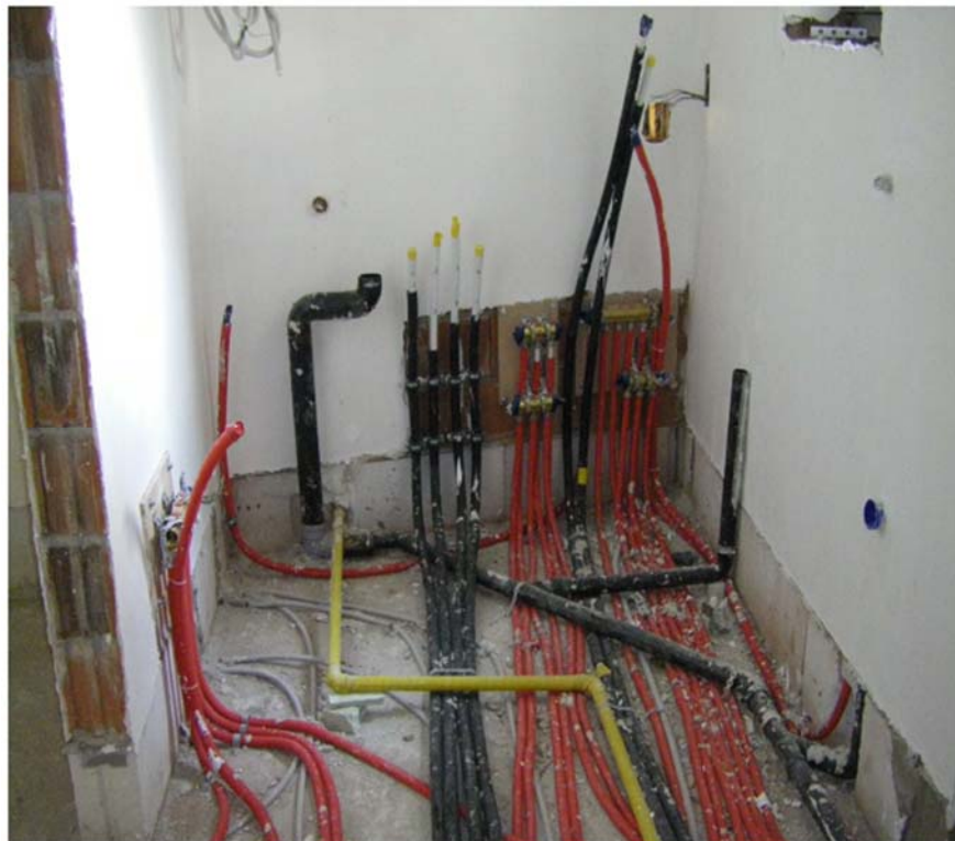
Afbeelding 1: Overmaat aan leidingen die bezettingswerken bemoeilijken (Foto: Bob De Lathouwer)
