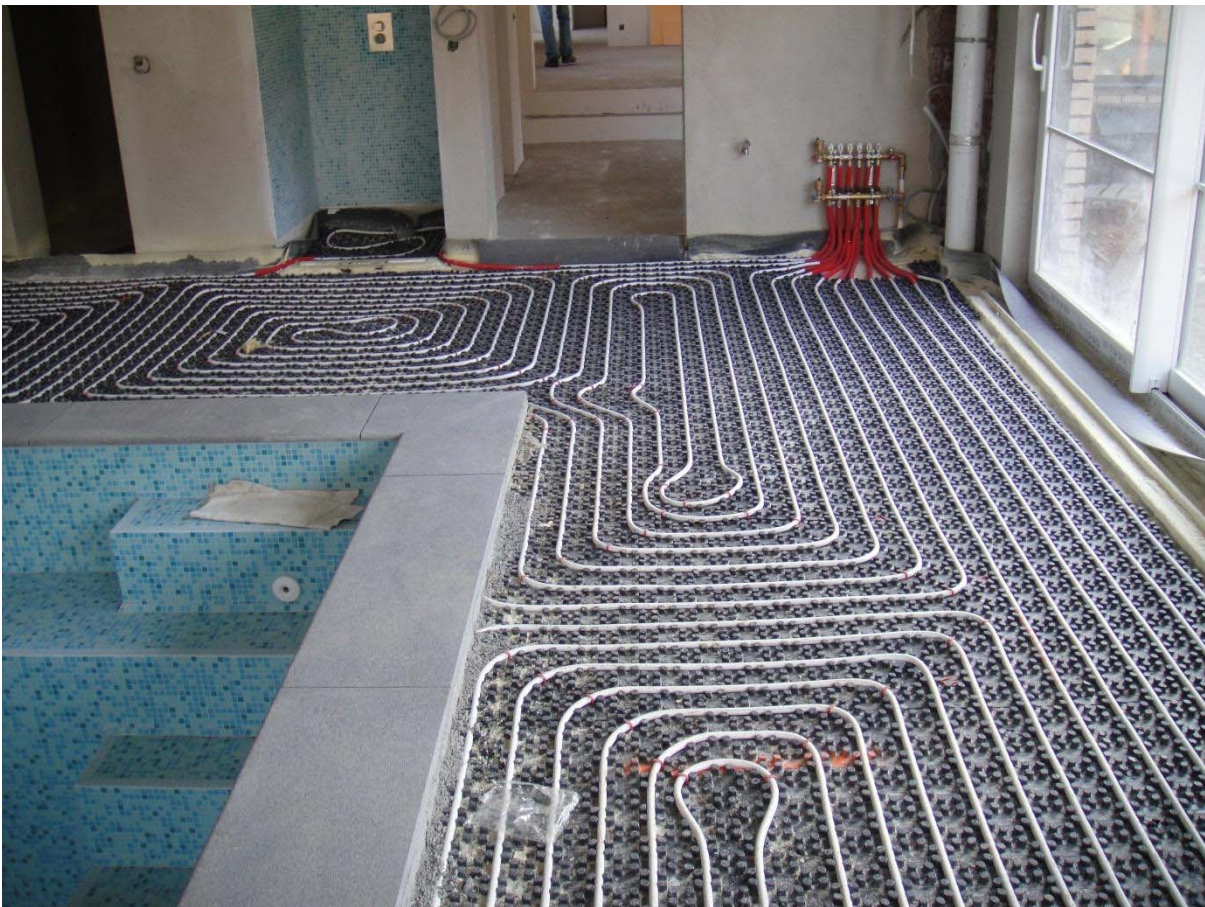
Afbeelding 2 : aanbrengen van vloerverwarmingsbuizen en collectoren na bezettingswerken
