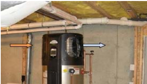
Figuur 13: Opstelling met goede luchtstroom
